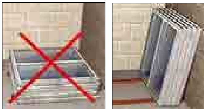
شکل ۲۰ روش‌های درست و نادرست انبار کردن پنجره‌ها
