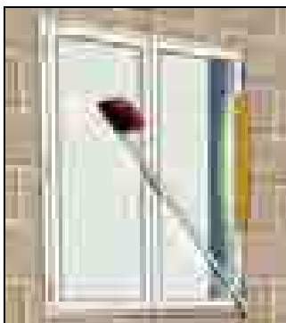
شکل ۶۰ لزوم حصول اطمینان از تساوی قطرهای (برای کنترل گونیا بودن پنجره)
