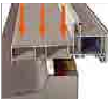
شکل ۶۵ اجرای درزبند خمیری پس از نصب ته‌بند
