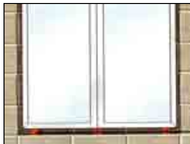
شکل ۴۷ جانمایی لاتن‌های بستر چارچوب
