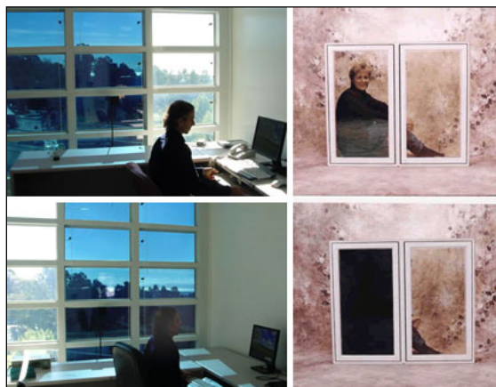
شکل ۱۲-۷۵- نمونه عملکرد پنجره‌های با شیشه‌های الکتروکرومیک
