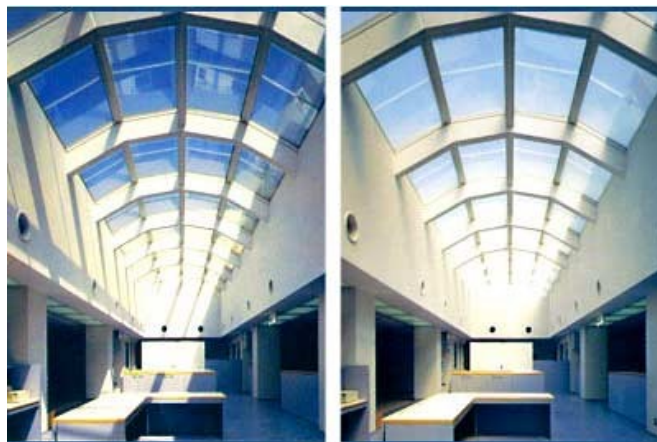
شکل ۱۲-۷۲- نمونه پوشش شفاف سقف با شیشه‌های فتوکرومیک
